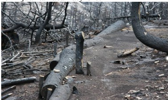
Fig. 5: Vendosja e trungjeve perpendikulare me pjerrësinë e terrenit
