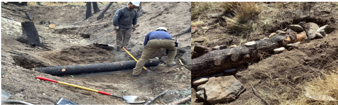
Figura 10. Vendosija e trungjeve të djegur sipas izoipseve për frenimin e erozionit
