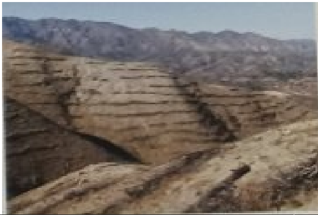
Fig. 8. Grumbullimi dhe vendosja në breza e materialit drusor të djegur (e përzier me breza trungjesh në formë terracash).
