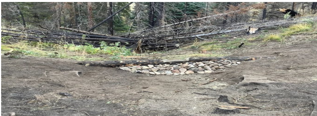
Fig. 11. Vendosija në grumbuj e materialit drusor të djegur dhe gurëve për frenim të erozionit
