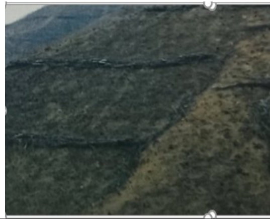
Fig. 9. Grumbullimi dhe vendosja në breza materialit drusor të djegur sipas vijave të izoipseve.
