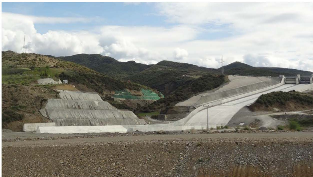
Figura 9.2: Diga e Banjës, e cila tregon rrjedhën e përmbajtjeve dhe mbrojtjen e argjinaturës në rrjedhën e poshtme.
