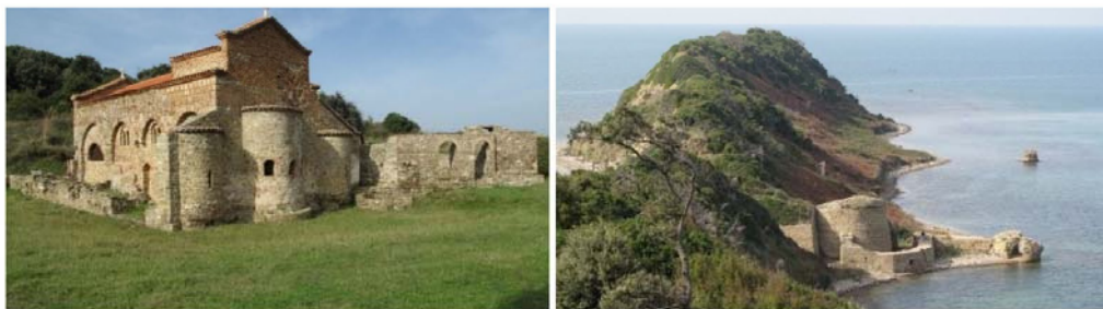
Figura 119 –Majtas, Kisha e Shena' Ndout, pas restaurimit Figura 120 –Djathtas, Kalaja e Currilave, kulla dhe porta kryesore
