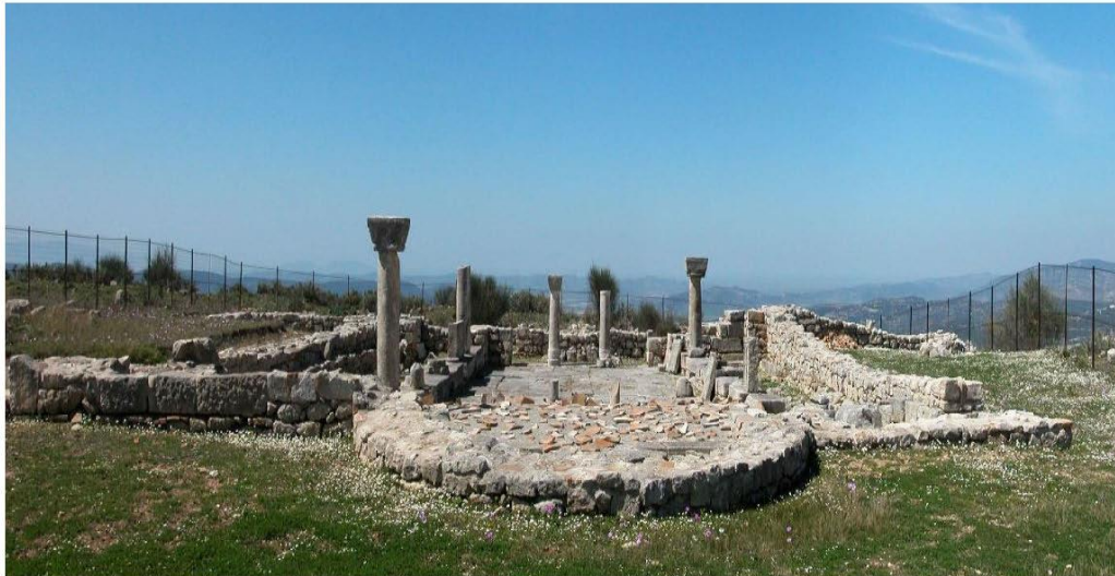
FIGURA 24 - BYLIS. BAZILIKA C. FOTO N. CEKA
