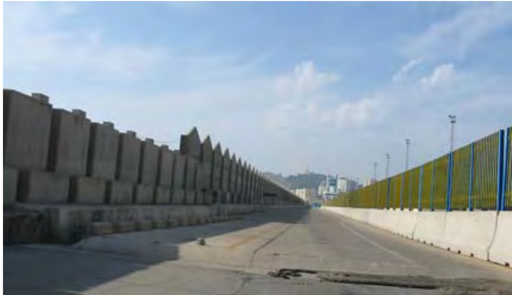
Figure 6-2 Rampa e krijuar nga nderprerja e punimeve.
