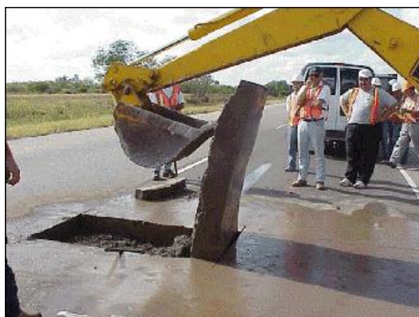
Figura 1.20: Ngritja e bllokut te Asfalto-Betonit (AB) me prapaeskavator
