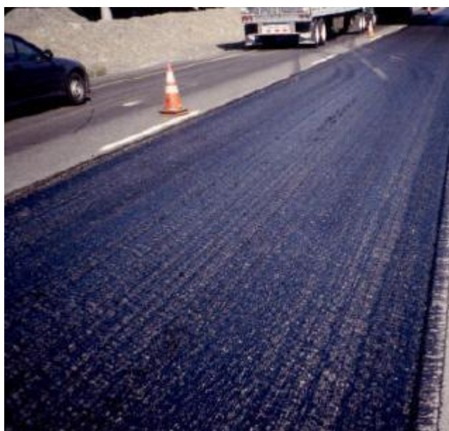
Figura 8.19: Veshje me primer duke përdorur emulsion asfalti. Ngjyra e zezë tregon se është “prishur”.
