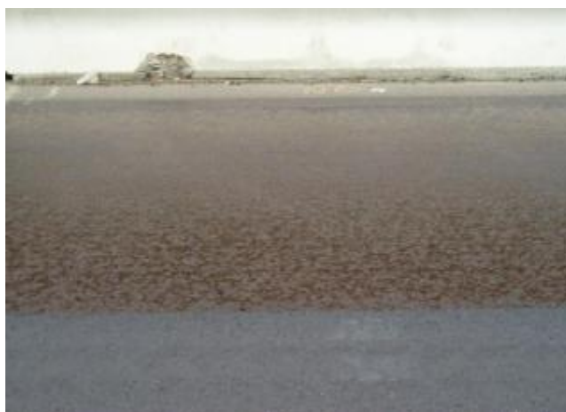
Figura 8.17: Shtresë primeri e sapo vendosur. Ngjyra kafe tregon se ende nuk është “prishur”.
