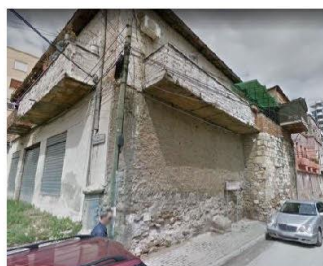
Figurë 43 - Rrënojat e mureve të fortifikimit që përfshihet në ndërtesa
